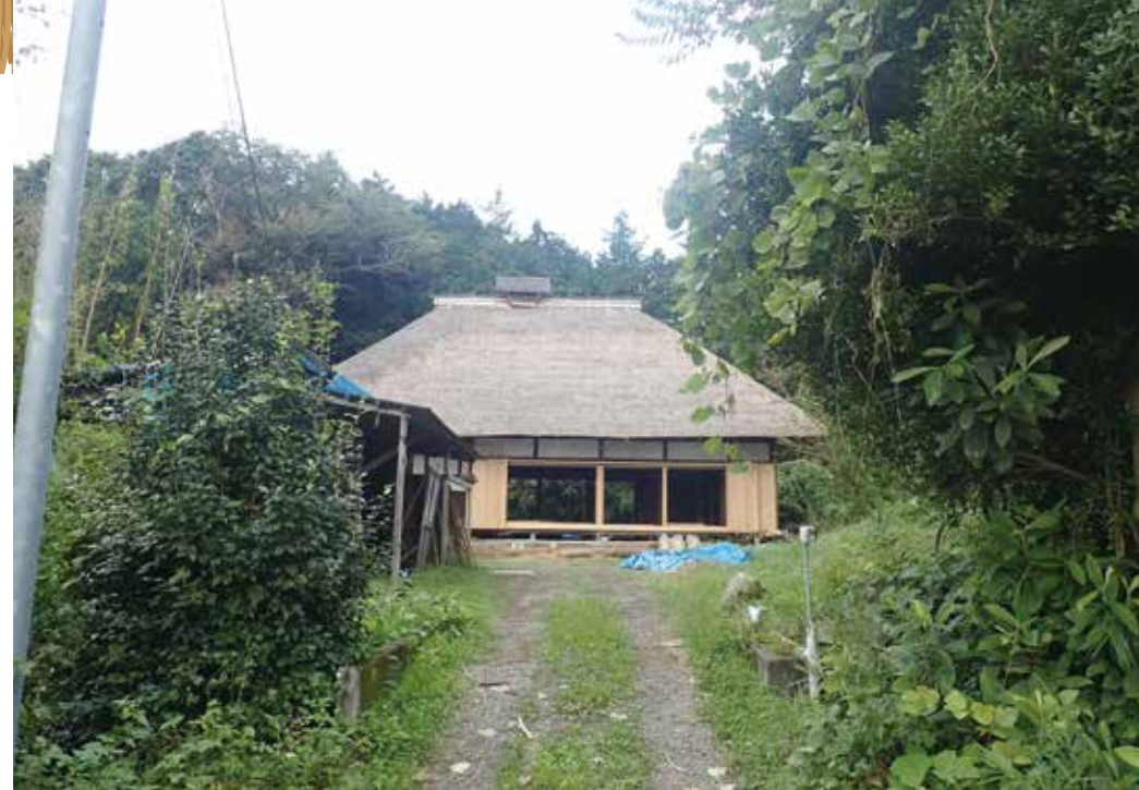
サンプリングに訪れた茅葺再生プロジェクトが進行中の茨城県八郷町の茅葺民家（2020年10月12日）
